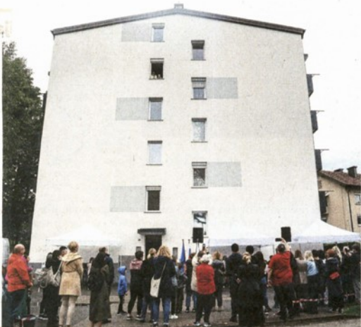
Blok na Ptujski ulici 26 je po celoviti vizualni in energetski prenovi postal najlepši blok leta 2024. © Jaka Gasar
